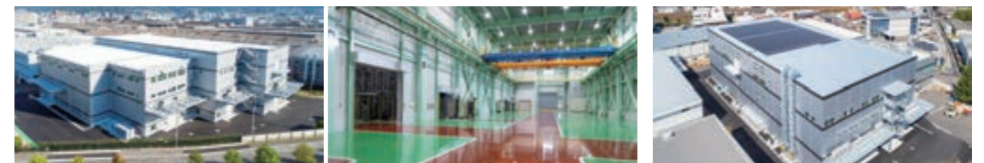
第九組立工場（2階建て、延床面積9,043㎡）
