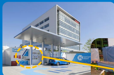
水素ステーション
