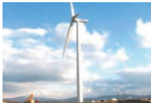
島根県益田市高津町に設置した当社製風力発電システムJ82
