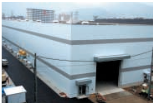
平成20年7月の稼動を目指し建設が進む新組立工場
